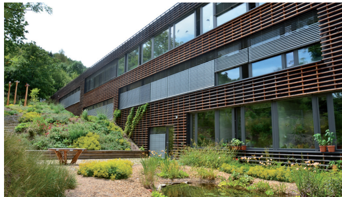
Obr. 1 Pohled na VJV fasádu: žaluzie jsou děleny – lamely v cca horní čtvrtině je možné natočit odlišně od zbylé části a umožnit tak difúzní osvětlení interiéru
