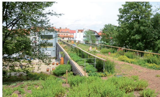
Obr. 2 Pohled na ZSZ fasádu a střechu, přecházející do svahu: vlevo je navazující budova B (šedá), vpravo stromy, stínící VJV fasádu
