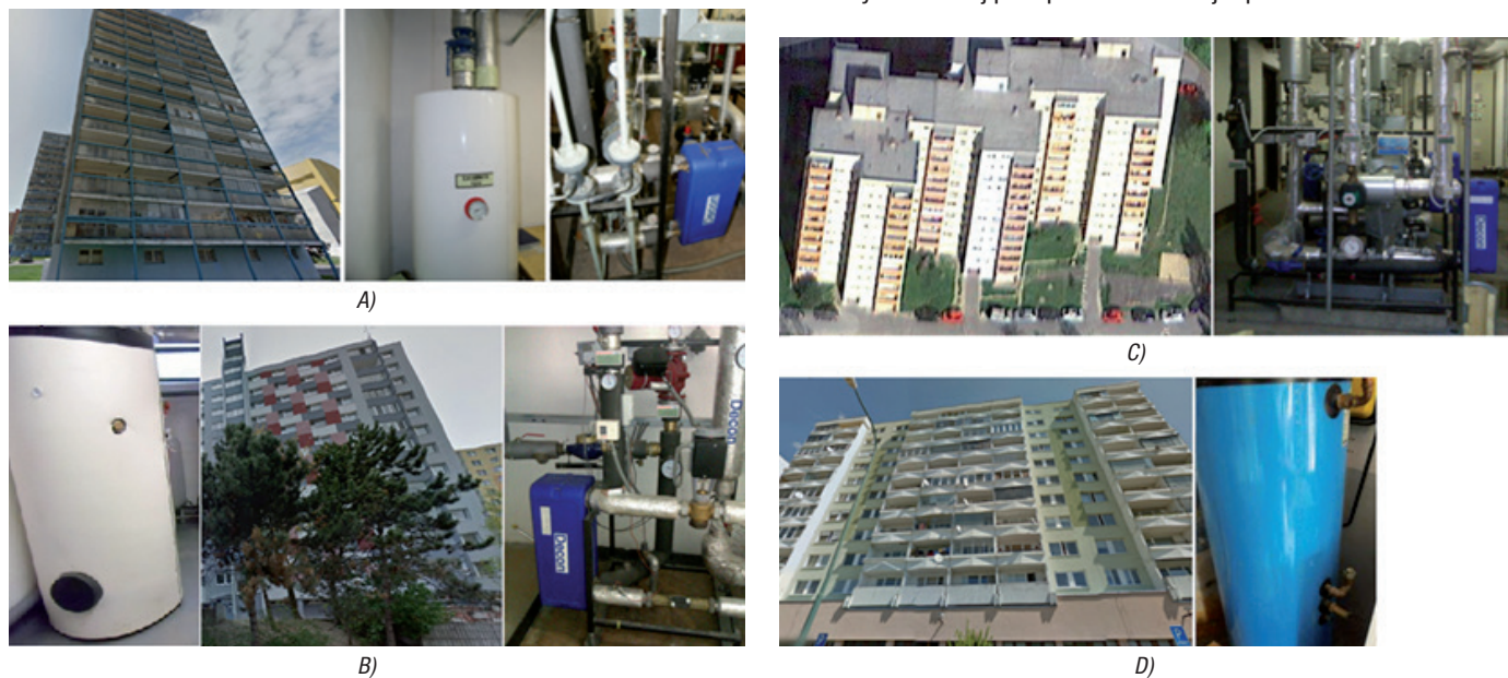
Obr. 1 Bytové domy, ktoré boli využité pri experimentálnych meraniach a pohľad do ich odovzdávacích staníc: A) bytový dom s 156 obyvateľmi; B) bytový dom s 196 obyvateľmi; C) bytový dom s 306 obyvateľmi; D) bytový dom s 159 obyvateľmi
