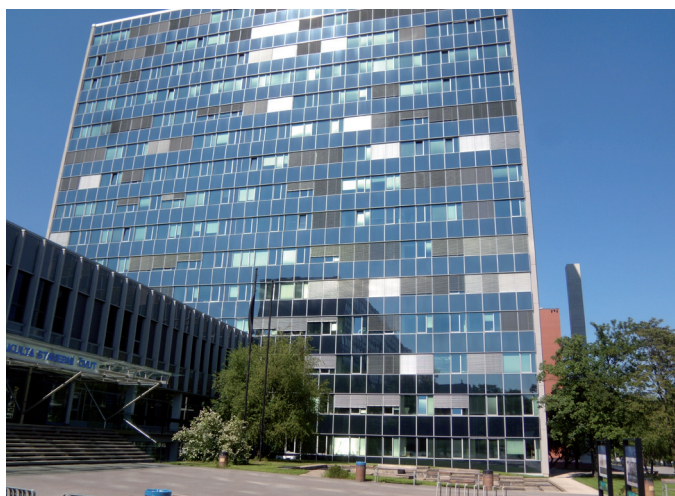
Obr. 3 Budova „A“, ČVUT, Fakulta stavební, JZ fasáda, 19. 5. 2017 v 15.00 hodin, přibližně 2/3 žaluzií jsou vytaženy
