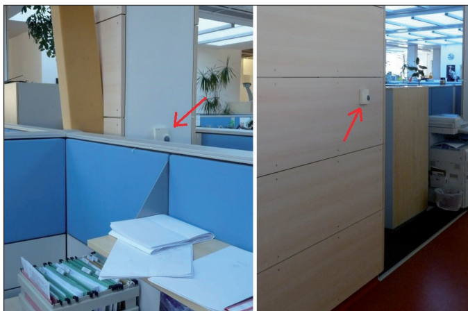
Obr. 15 Některá čidla pro regulaci sekcí CHIT jsou částečně zakryta nábytkem (vlevo) a umístěna v komunikačním koridoru (vpravo)
