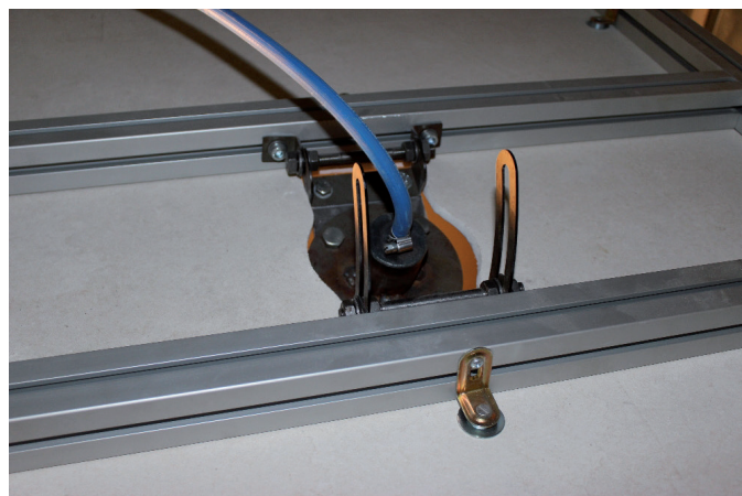
Obr. 8 Detail napojení hadice na hasicí zařízení
