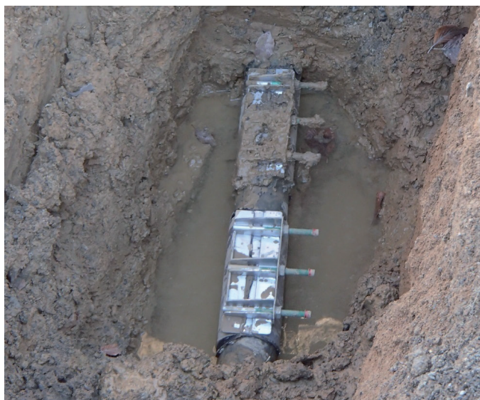
Obr. 6 Oprava prasklého potrubí – 2× opravná objímka (třmen) (zdroj: archiv autora)
