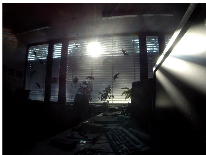
Obr. 7 Ukázka stavu žaluzií v kanceláři 2.09: žaluzie staženy do polohy 4 (zcela staženo), horní čtvrtina žaluzií je nakloněna do přibližně vodorovné polohy (neznámá solární propustnost), zbylé tři čtvrtiny žaluzií nakloněny v poloze zavřeno – nepropustné
