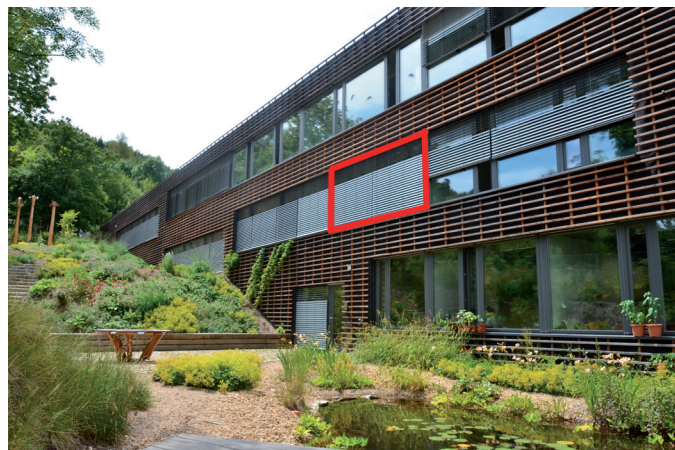
Obr. 1 Pohled na JVJ fasádu: žaluzie jsou děleny – lamely v cca horní čtvrtině je možné natočit odlišně od zbylé části a umožnit tak difúzní osvětlení interiéru; červeným rámečkem je vyznačena poloha měřené kanceláře
