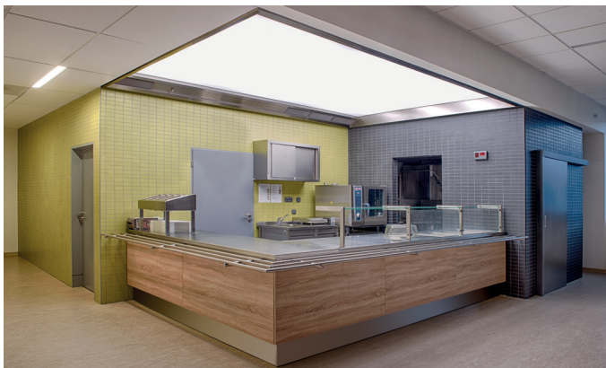
Obr. 9 Otevřená kuchyně vybavená uzavřeným větracím stropem (integrované odsávací vzduchovody s tukovými filtry jsou umístěny po stranách větracího stropu)
