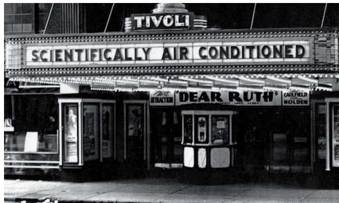
Obr. 3 Příklad uplatnění klimatizace (zdroj: [31])
