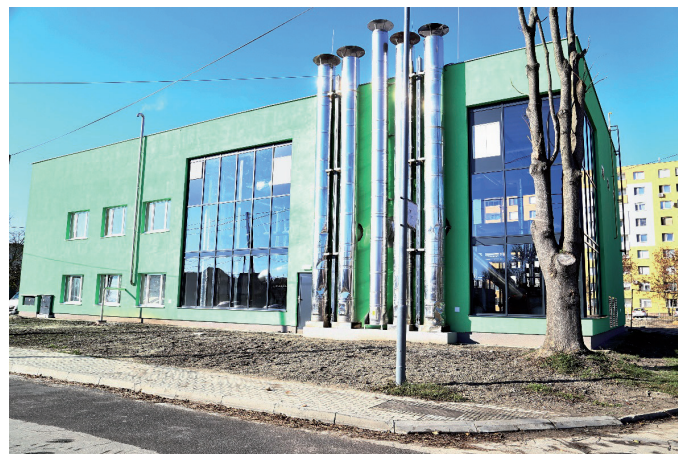
Obr. 7 Pohľad na zrekonštruovaný zdroj tepla – teplovodná kotolňa na zemný plyn Fig. 7 View of the reconstructed heat source – hot water boiler house for natural gas
