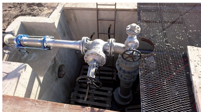
Obr. 1 Hlava geotermálneho vrtu VM-1 vo Veľkom Mederi
