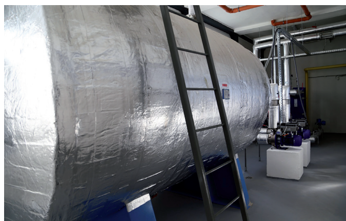
Obr. 4 Ležatá odplynovacia a akumulačná nádrž s objemom 10 m 3
