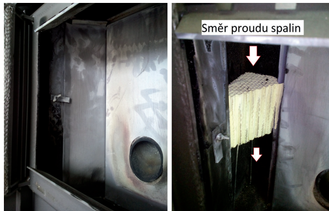
Obr. 5 Spalovací komora (vlevo); umístění katalyzátoru v druhém tahu (vpravo) – šipky vyznačují směr proudění spalin
