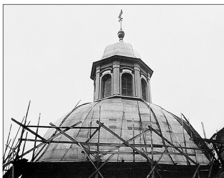
Obr. 8 Kaple odvětrávaná lucernou
