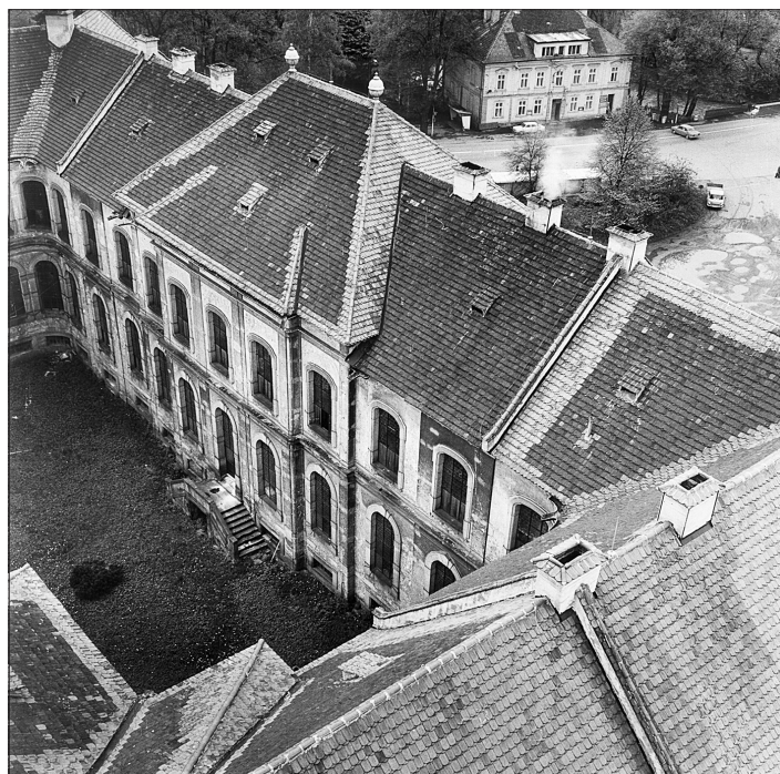
Obr. 7 Střechy jsou větrány otvory ve vikýřích, aby nedocházelo k akumulaci tepla a vlhkosti v půdních prostorách.
