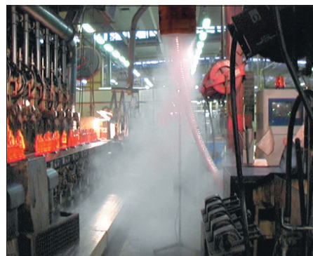
Obr. 6 Vizualizace proudění vzduchu z horní vzduchové sprchy na pracovním místě u sklářské linky
