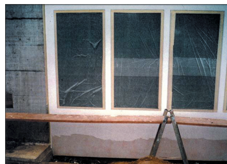
Obr. 5 – Aplikace tepelně izolačních desek Sto Therm Solar
