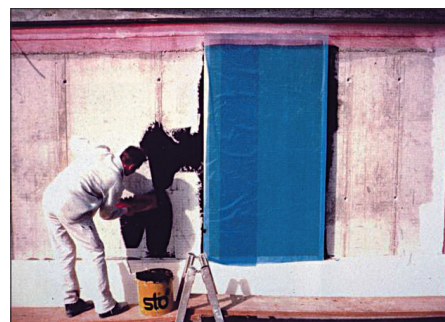
Obr. 4 – Nanášení lepicí hmoty na železobetonovou stěnu
