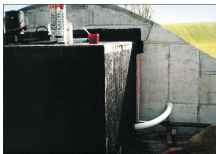
Obr. 2 – Hydroizolační povlak na železobetonové konstrukci
