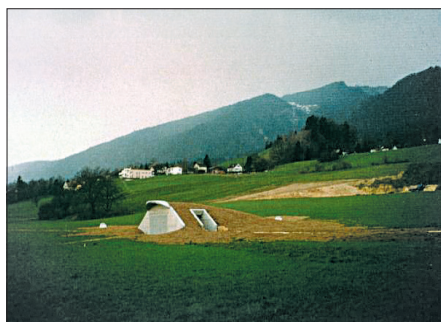
Obr. 1 – Celkový pohled na vodárenský objekt
