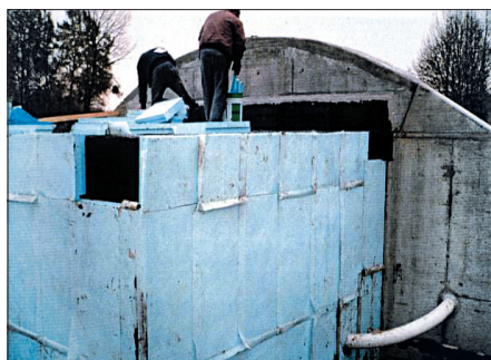
Obr. 3 – Instalace tepelné izolace z extrudovaného polystyrénu
