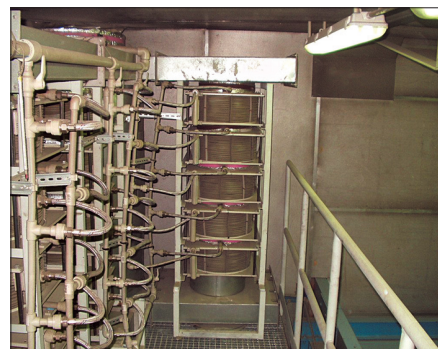
Obr. 5 – Sestava výměníků v kabině.
