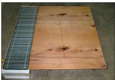
Obr. 5 – Instalace konvektoru – „IZ+N. deska“
