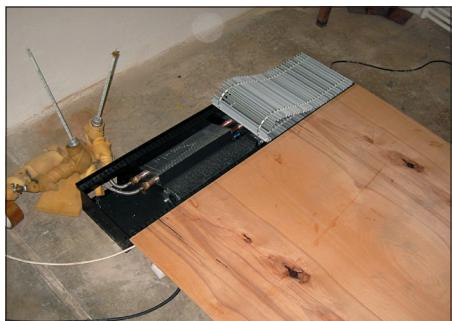
Obr. 3 – Instalace konvektoru – „Konv.+N. deska“
