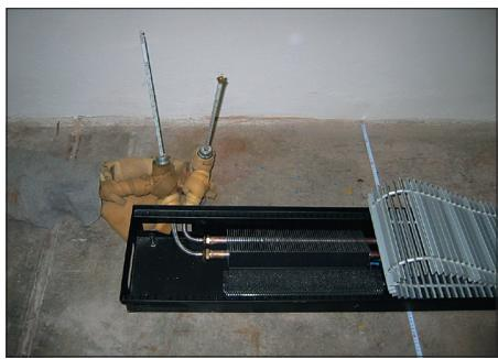
Obr. 2 – Instalace konvektoru – „Jen Konv.“
