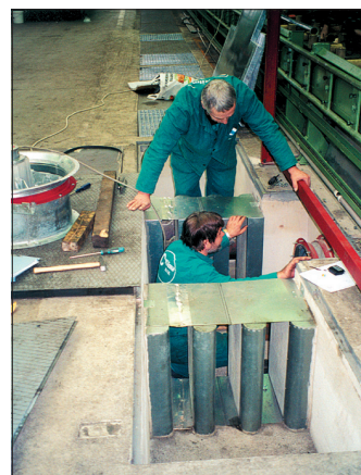
Obr. 6 – Montáž tlumičů hluku a ventilátoru na sací straně
