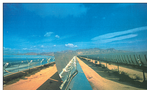
Obr. 4 – Zdrojová část sluneční elektrárny, pracující bez akumulace energie (podle [4])
