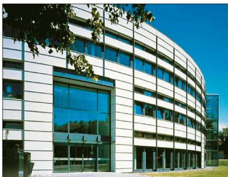
Obr. 5 – Budova Fraunhoferova institutu ISE se vyznačuje svou štíhlostí. Vzhledem k úspoře elektrické energie a účinné protisluneční ochraně jsou vnitřní a solární tepelné zátěže tak zredukovány, že budova může být ochlazována výhradně zemními tepelnými výměníky. (Architekti: DIS-SING +WEITLING. Technické vybavení budov: Rentschler & Riedesser. Energetická koncepce: Fraunhofer IUV ISE)
