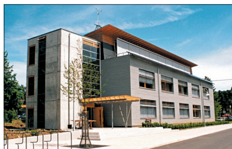
Obr. 1 – V administrativní budově Lamparter ve Weilheimu je letní tepelná ochrana řešena účinnou protisluneční ochranou, nočním větráním a zemním výměníkem tepla vtělena do koncepce pasivního domu. (Spolek architektů Weinbrenner Single. Energetická koncepce: Fraunhoferův ISE.)
