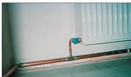
Obr. 4 – Jezdecké napojení ÚT – přívod s nízkoodporovou armaturou
