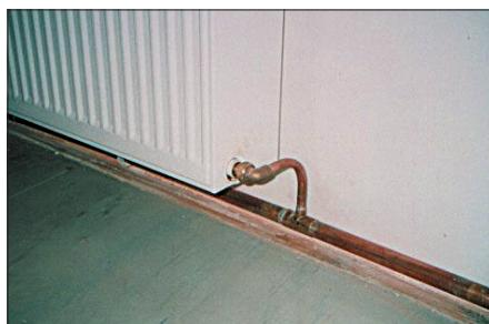
Obr. 5 – Jezdecké napojení OT – zpětná přípojka s roho-vým šroubením
