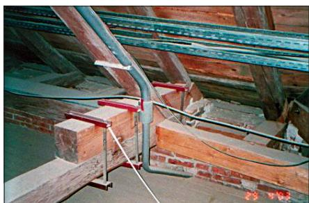
Obr. 2 – Odbočky až k uzávěru jsou ocelové, za uzávěrem měděné
