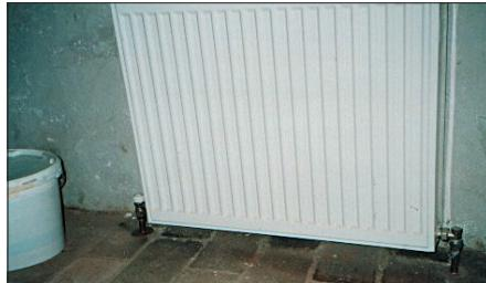
Obr. 8 – Při dodávkách jinou firmou byly použity vysokoodporové armatury a uzavírací regulační šroubení – obojí bylo nutno vyměnit
