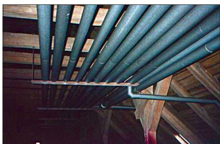
Obr. 1 – Horní rozvody v půdním prostoru jsou ocelové
