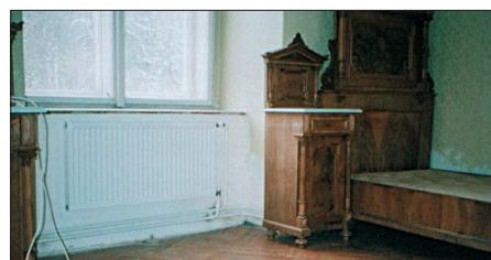
Obr. 9 – Malá část byla realizována dvoutrubkovým rozvodem, později zakrytým interiérovou lištoú
