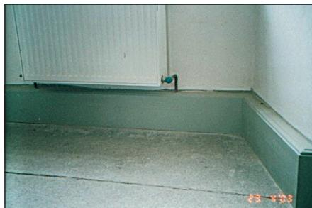
Obr. 6 – Krycí lišta odpovídá stávajícímu ostění
