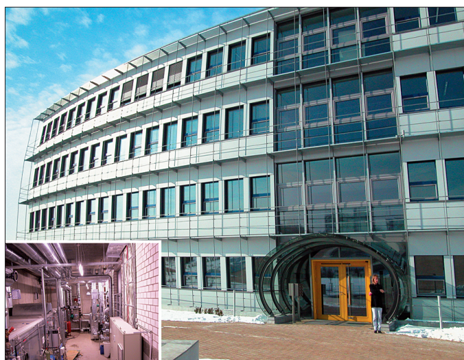
Obr. 5, 5a Pasivní administrativní budova
