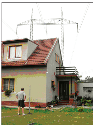
Obr. 1 Obytná budova v Odolené Vodě, ve které byly měřeny velikosti intenzity elektrického a magnetického pole
