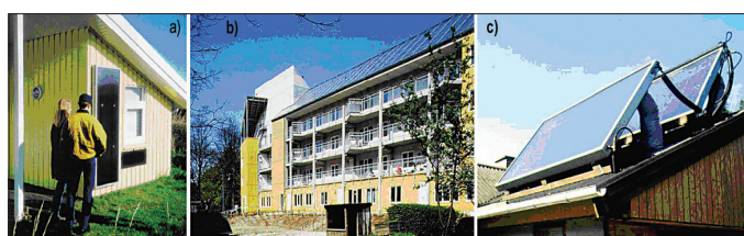
Obr. 2 Příklady instalací solárních vzduchových kolektorů v bytové a občanské výstavbě a – malý solární vzduchový panel na rekreační chatě b – energetická střecha jako vzduchový kolektor 150 m 2 na bytovém domu v Kodani, Dánsko c – dva hybridní solární kolektory vzduch/kapalina (cirkulující kapalná náplň uvnitř kolektorů)
