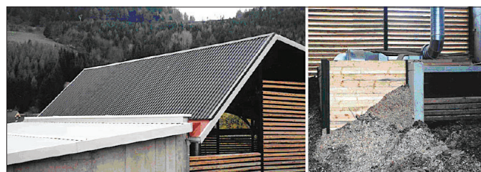
Obr. 4 Teplárna CZT Klein St. Paul a – solární střešní kolektor, b – přívod teplého vzduchu pod sušicí rošt
