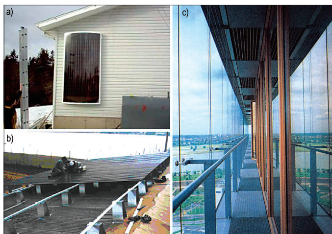
Obr. 1 Rozdělení vzduchových systémů – příklady a – průmyslově vyráběný panelový plochý kolektor (teplovzdušné vytápění) b – montáž integrované absorpční střechy skladové haly (sušení zemědělských produktů) c – energetická fasáda administrativní budovy (předehřev větracího vzduchu, odvod letních tepelných zisků)
