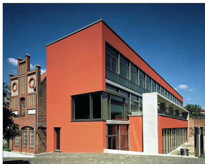
Obr. 2 Centrum pro udržitelnou výstavbu – Kassel, Německo [20]
