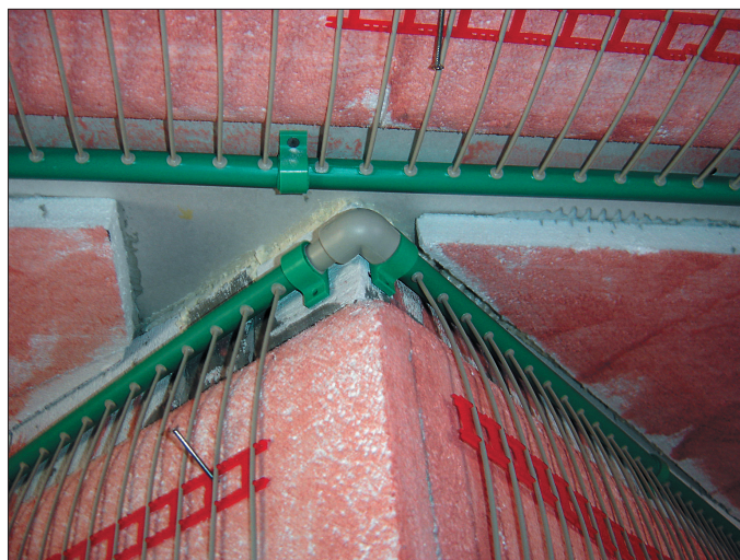
Obr. 3 Detail umístění kapilárních rohoží u rohu místnosti
