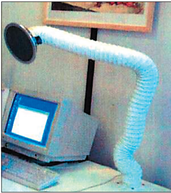
Obr. 7 Zdokonalený koncový prvek na otočném rameni (Round Movable Panel) představující nejvyšší dosaženou účinnost osobního větrání (až 95 % ve vzdálenosti 0,4 m od obličeje uživatele) (Bolashikov, Nikolaev, 2003)
