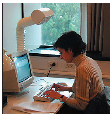
Obr. 5 Koncový prvek umístěný na pohyblivém ramenu (Movable Panel) umožňuje libovolné nasměrování proudu čerstvého vzduchu Ovládací panel pro nastavení průtoku přiváděného vzduchu je pod deskou stolu (Melikov a kol., 2001)
