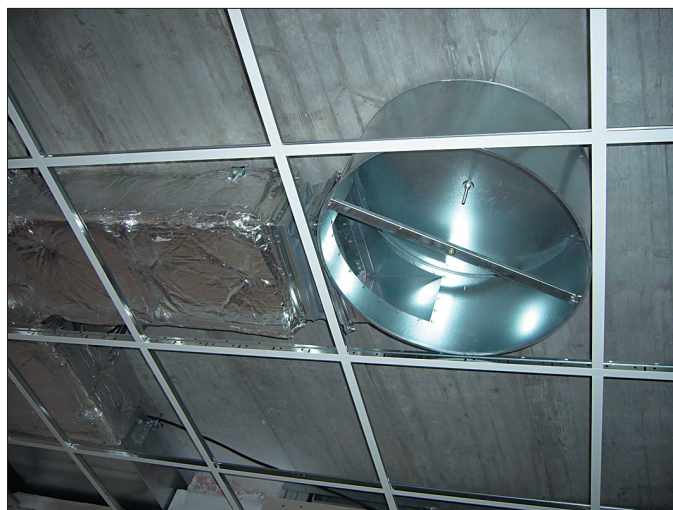
Obr. 2 Tangenciální napojení připojovacího boxu čtyřhranným potrubím
