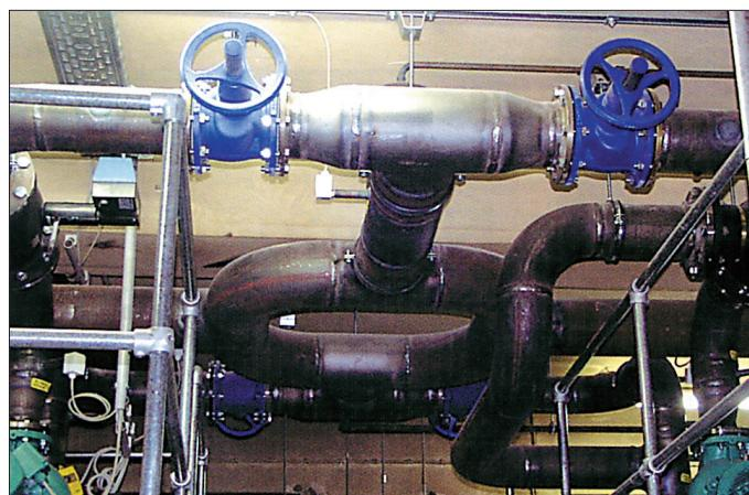
Obr. 7 Pohled na hydraulický věnec při paralelním zapojení kotlů (Instandhaltungswerk der Deutsche Bahn AG – Frankfurt am Main)
