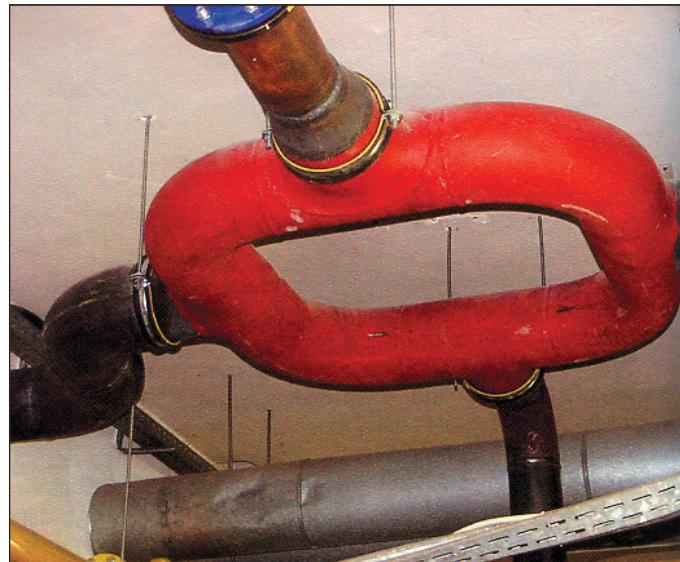
Obr. 1 Pohled na hydraulický věnec
