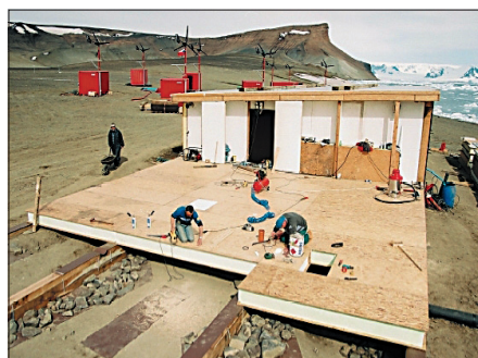
Obr. 12 Zakládání a montáž stavby V pozadí již rozmístěné kontejnery malými větrnými elektrárnami (8 kusů po 1,5 kW)
