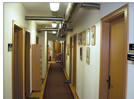
Obr. 15 Pohled do chodby stanice
