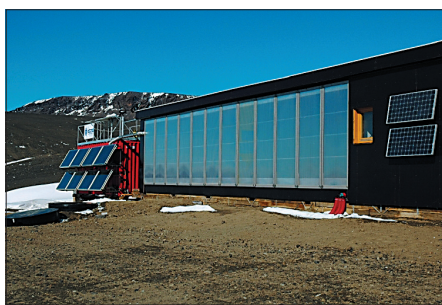
Obr. 20 Severní fasáda stanice s vestavěným teplovzdušným kolektorem, FV články a kontejner s kapalinovými kolektory na ohřev vody
