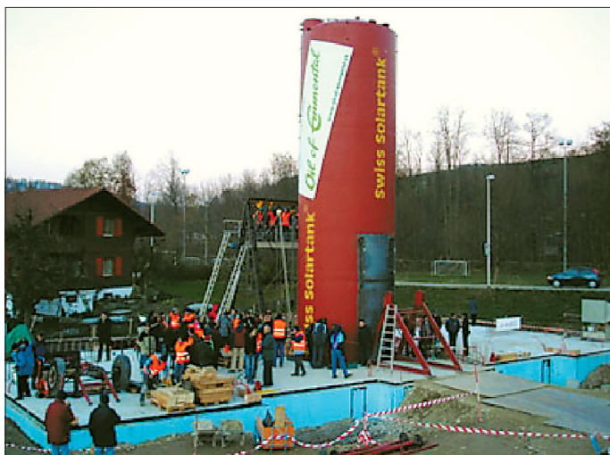
Obr. 13 Instalace sezónního zásobníku pro bytový dům Oberburg-Burgdorfu
