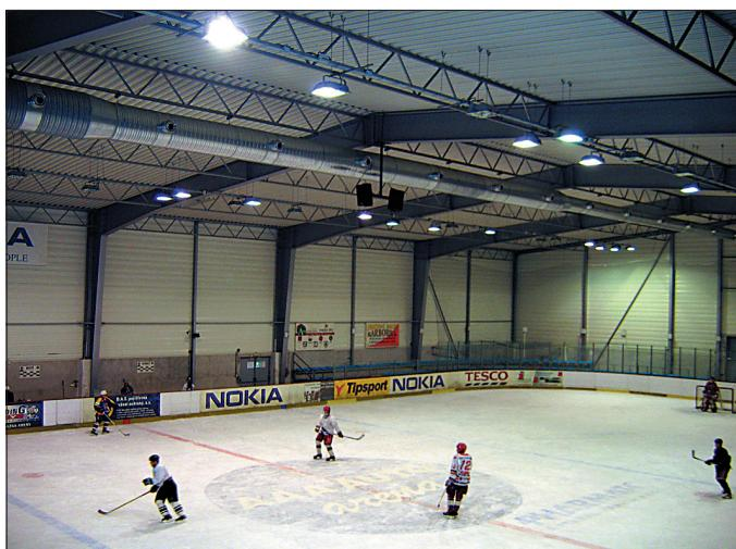
Obr. 1 Rozvod odvlhčeného vzduchu kruhovým potrubím se směrovatelnými tryskami
