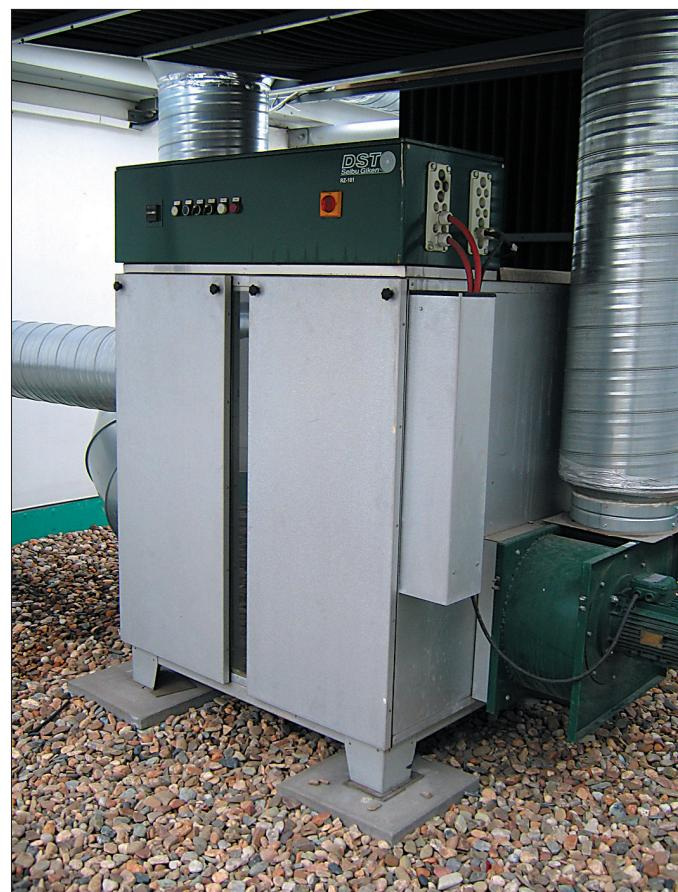
Obr. 5 Odvlhčovací jednotky DST RZ 102 na střeše stadionu v Letňanech
