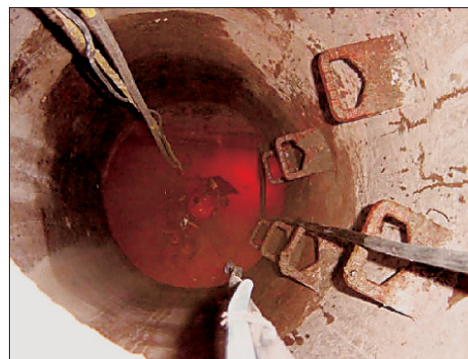
Obr. 4 Pohled do vstupní šachty k jímce
