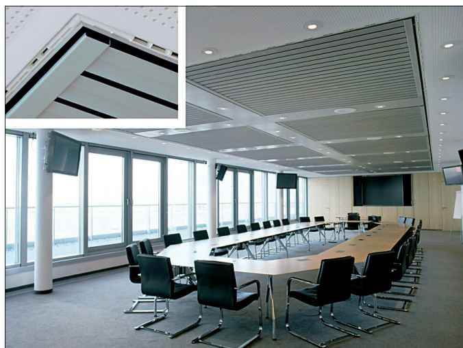
Obr. 10 Integrace otevřeného chladicího stropu do sádkartonového stropu [3]
