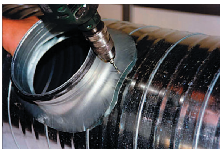
Obr. 8 Čistící otvor pro odsávací jednotku
