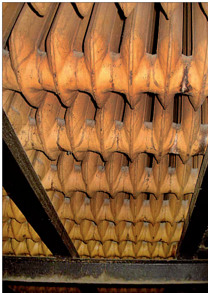
Obr. 9 Stávající parní výměník pro vytápění Pantheonu
