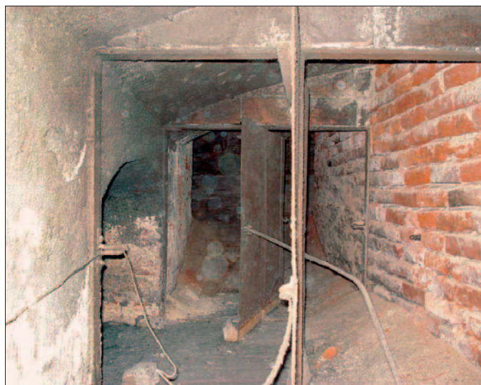
Obr. 2 Zbytky klapkového systému v kanálech
