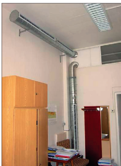
Obr. 2 Vyústění potrubí v severně orientované místnosti
