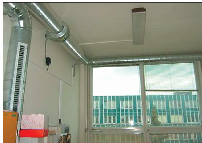
Obr. 1 Sací výústky nad okny v jižně orientované místnosti
