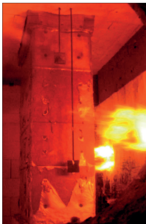
Obr. 1 Pohled na VZT potrubí při působení ohně zvnějšku potrubí (typ A)
