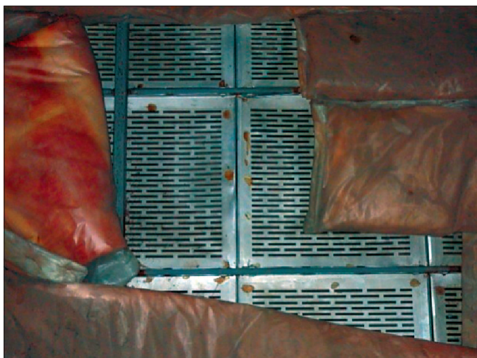
Obr. 9 Detail akustického obkladu stropu
