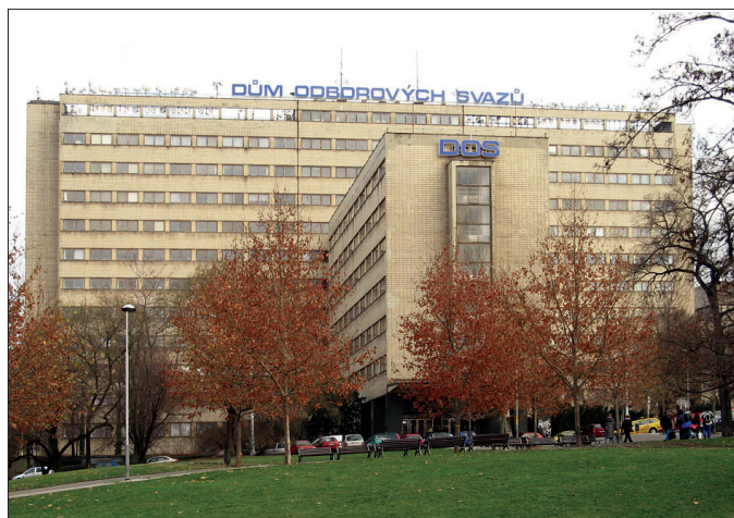
Obr. 1 Budova Všeobecného penzijního ústavu – dnes Dům odborových svazů
