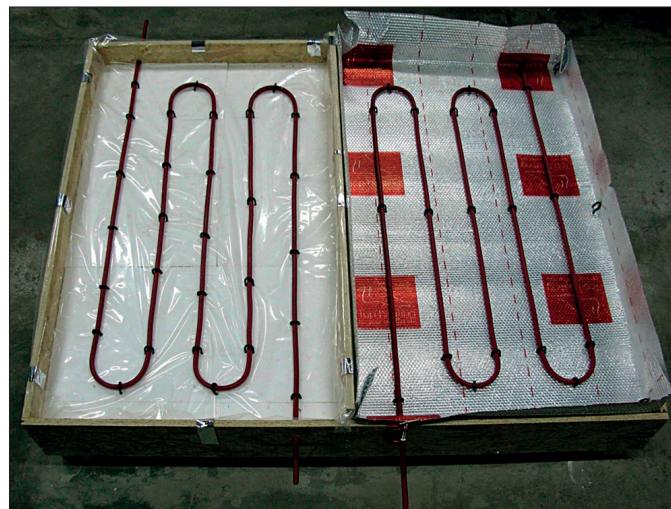
Obr. 2 Podlahová otopná plocha před betonáží
