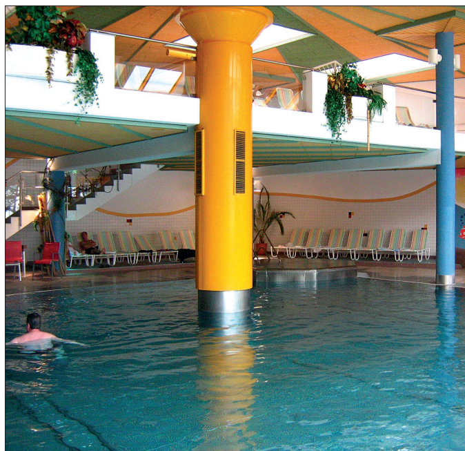
Obr. 6 Odvod vzduchu umístěný uprostřed vodní hladiny odvádí škodliviny přímo u zdroje
