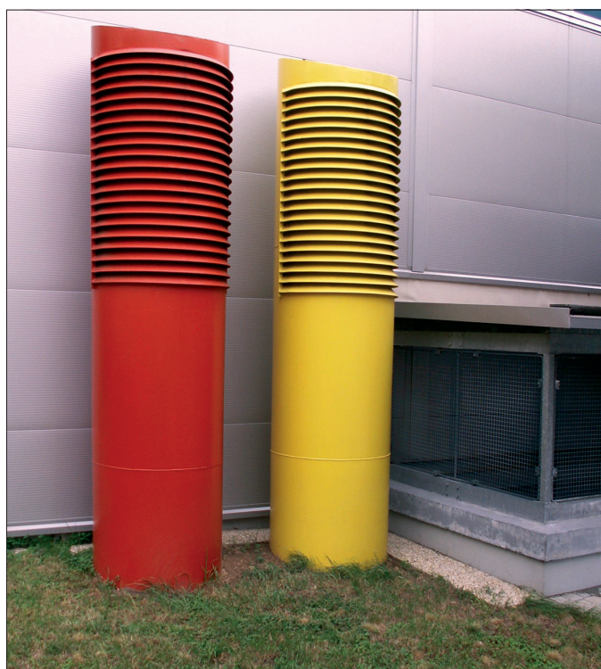
Obr. 7 Dva výfuky odpadního vzduchu nevhodné konstrukce v těsné blízkosti nasávací šachty negativně ovlivňují vnitřní prostředí celého aquaparku
