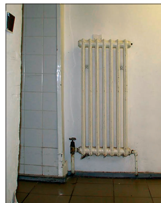
Obr. 2 Typické zapojení otopného tělesa
