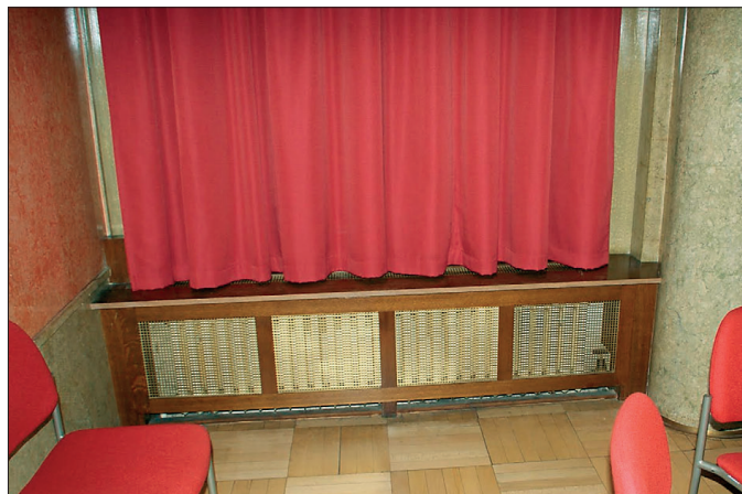
Obr. 3 Otopné těleso s krytem
