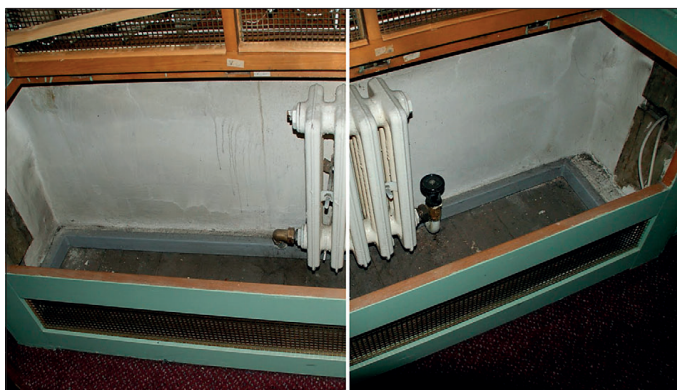
Obr. 5 Zapojení otopného tělesa pod krytem v sále Elišky Junkové
