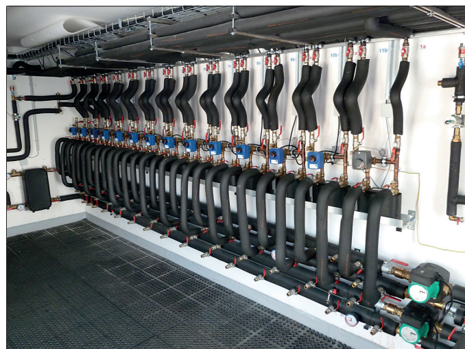
Obr. 6 Solární rozdělovač a sběrač
