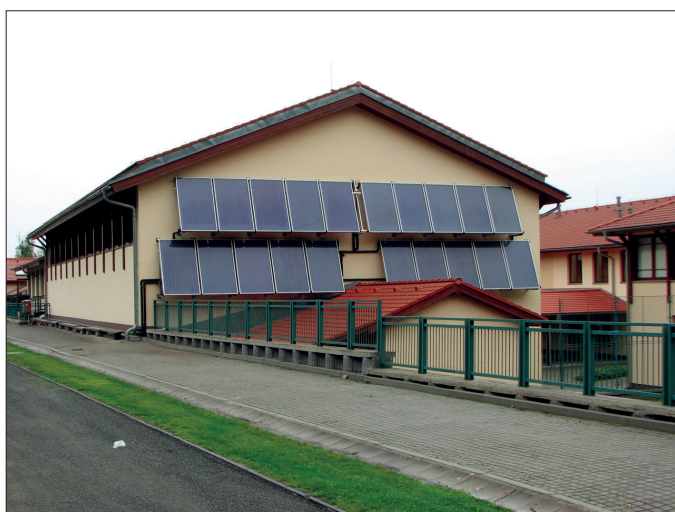
Obr. 2 Instalované sluneční kolektory
