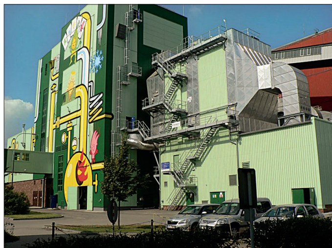
Obr. 1 Aktuální foto ze stavby „zeleného“ bloku
