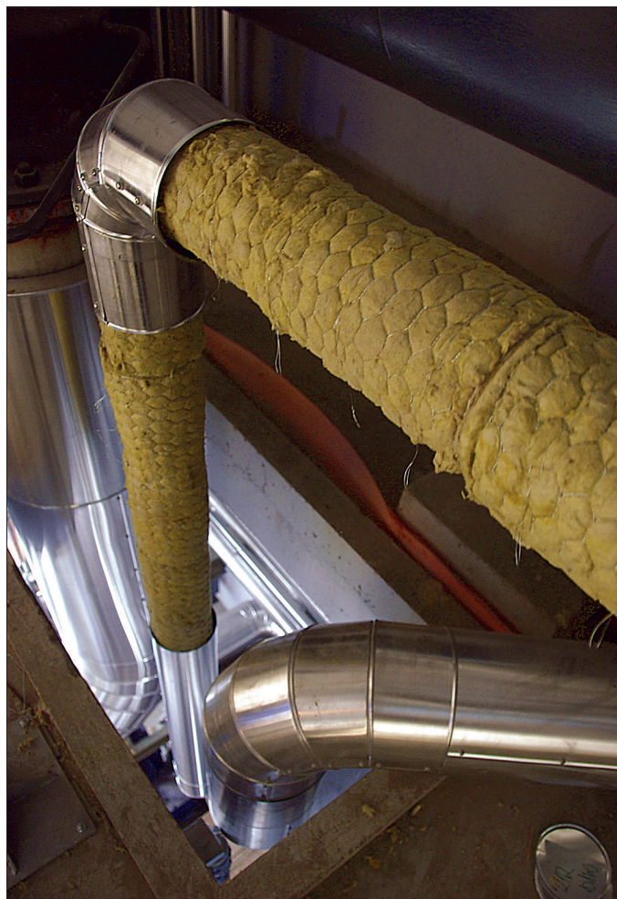
Obr. 1 Rohož na pletivu z minerální vlny je jedním z nejpoužívanějších izolačních materiálů pro izolování průmyslových zařízení nejen v energetice
