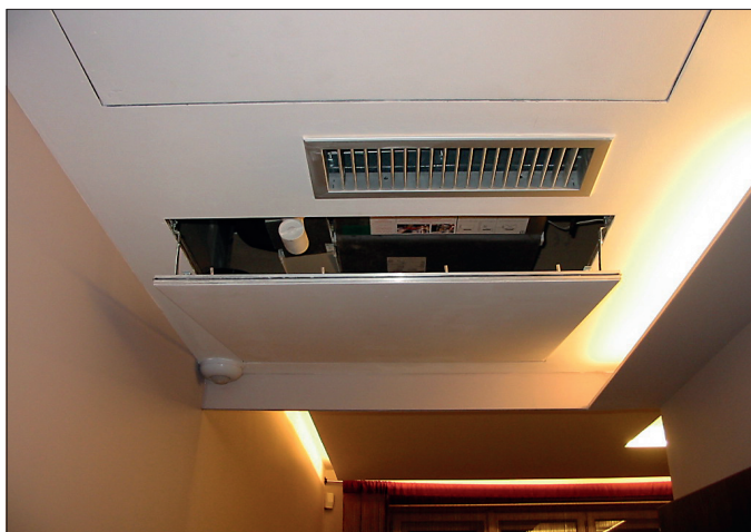
Obr. 3 Interiér pokoje (instalace FCU v pohledu stavební konstrukce)
