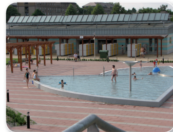
Solární systém pro aquapark v Ostravě
