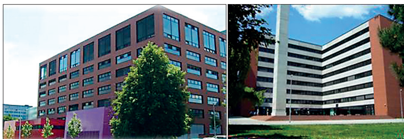
Obr. 1 Nová budova ČVUT – severní pohled vlevo a jižní pohled vpravo[3]
