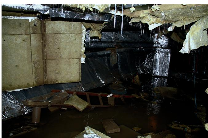
Obr. 5 Řádění vodního živlu se v mnohých stavbách nevyhnulo ani pod stropem umístěným vzduchovodům
