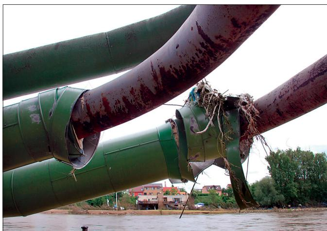
Obr. 9 Voda má v blízkosti toku tak velkou sílu, že na potrubí dokáže potřhat i plechové opláštění
