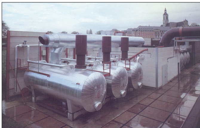
Obr. 5 Foto adsorpčního zařízení s parní regenerací nasyceného adsorbentu [4]
